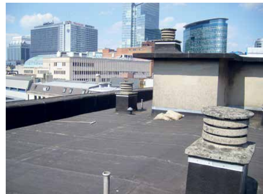
Toestand van het dak voor de renovatiewerken.
