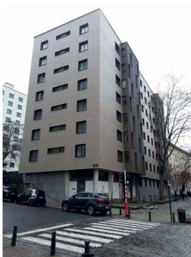
De bestaande, uitpandige terrassen langs de straatkant maken nu deel uit van de woonruimte.
