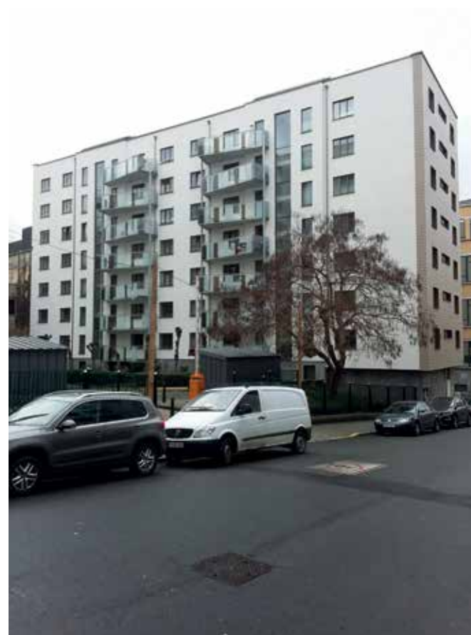
Beide sociale wooncomplexen zijn uitgerust met hedendaagse gevel- en dakisolatie en nieuwe terrassen.
