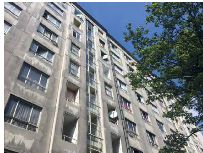
De gevel voor aanvang van de renovatiewerken.
