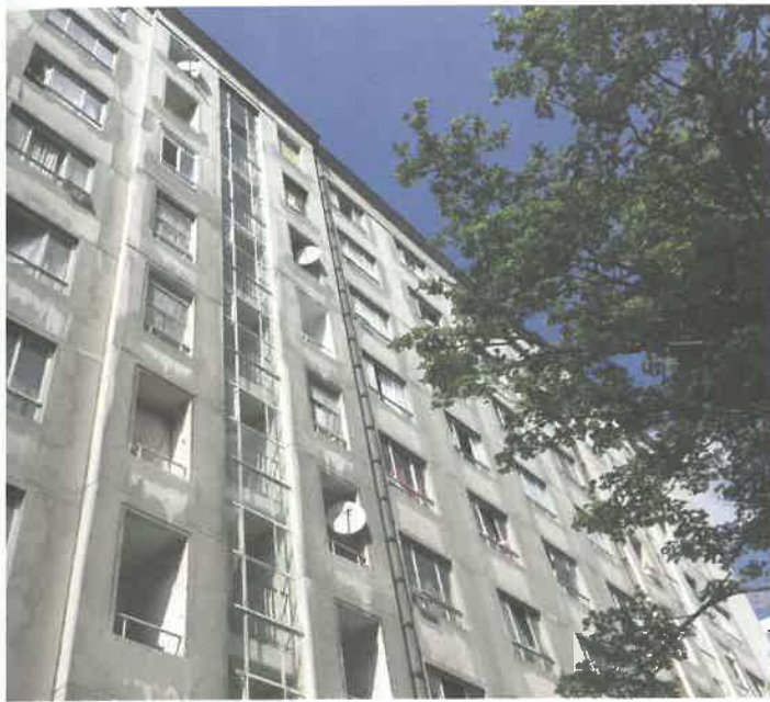
De gevel voor aanvang van de renovatiewerken.
