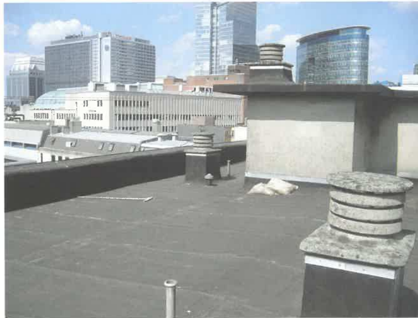
Toestand van het dak voor de renovatiewerken.
