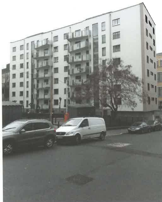
Beide sociale wooncomplexen zijn uitgerust met hedendaagse gevel- en dakisolatie en nieuwe terrassen.
