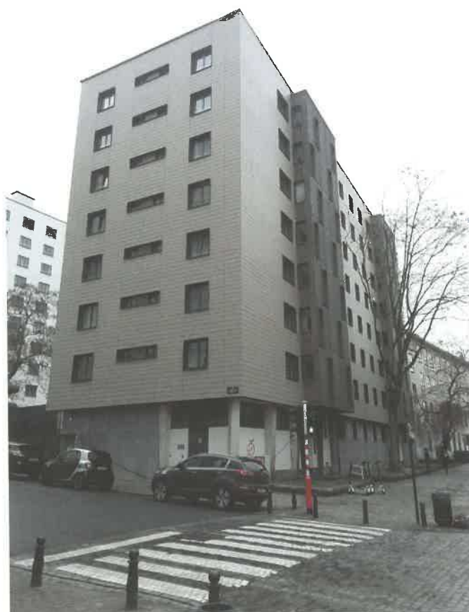
De bestaande, uitpandige terrassen langs de straatkant maken nu deel uit van de woonruimte.
